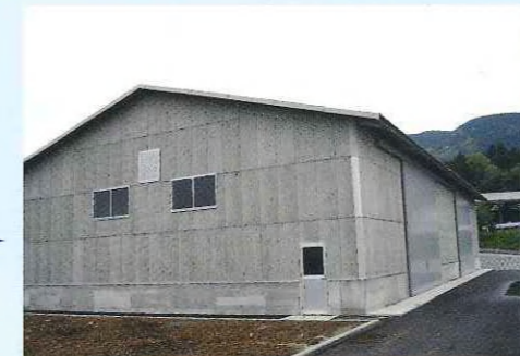
堆肥袋詰貯蔵倉庫 (袋詰品棟)
