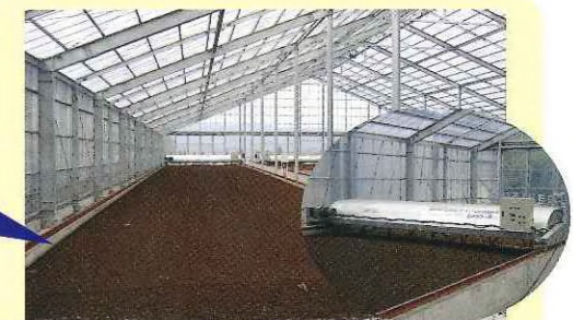
乾燥設備にて返送堆肥製造 (天日乾燥設備)
